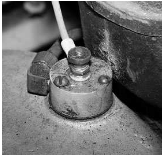
Bild der nachgerüsteten Außenschmierleitung.
